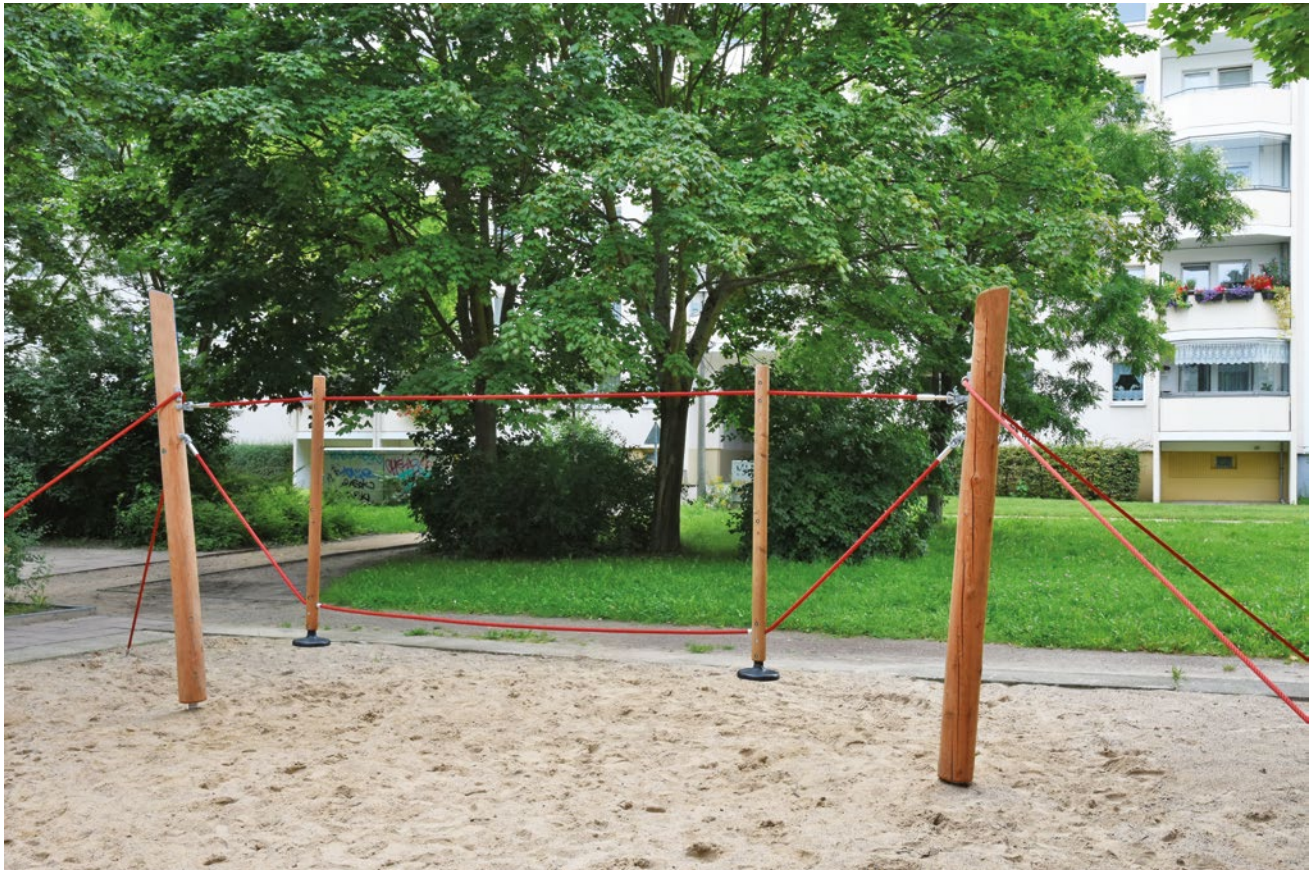
Das Foto zeigt abweichende Abspannseile
